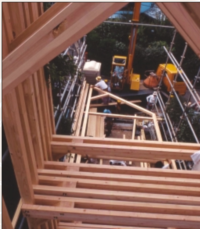
▷ Bouwfase; gelamineerde grenen kolom- men en liggers (hart op hart 600 mm).
